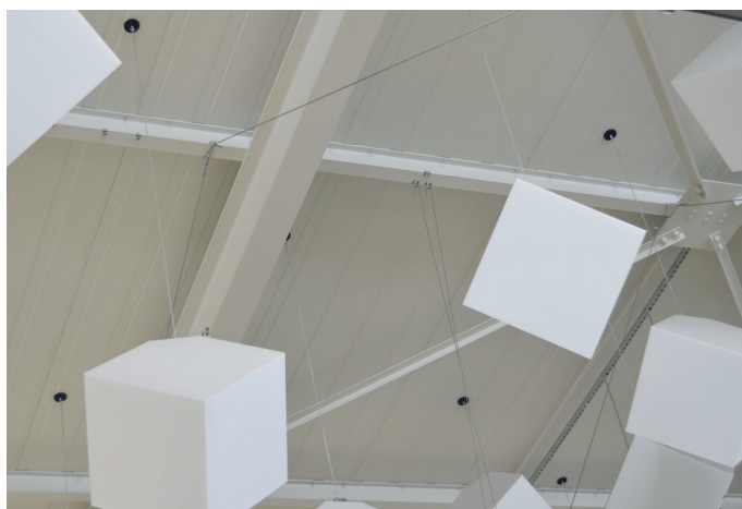
Suspension d'éléments d'insonorisation
