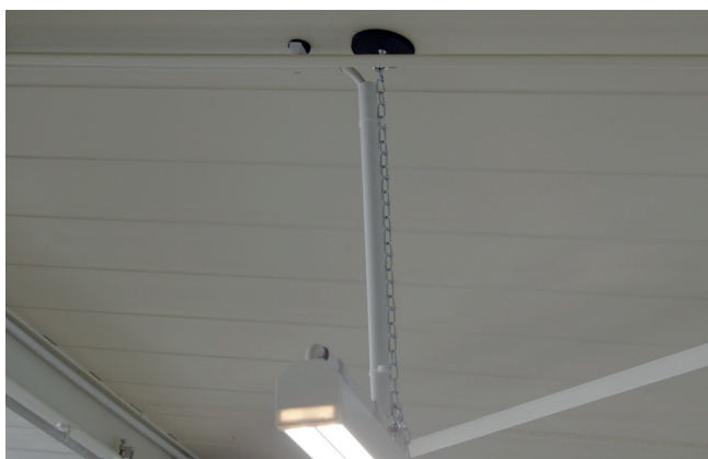
Suspendre les luminaires au plafond
