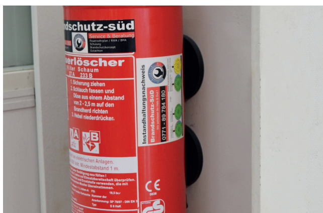
Fixation d'extincteurs, etc. directement sur la poutre en acier
